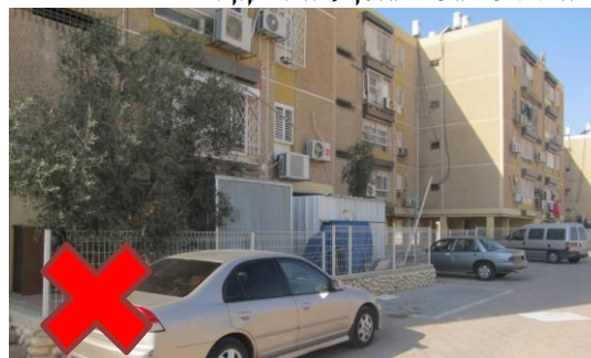
איור 5 : מחסנים בחריגה מקו בנין
